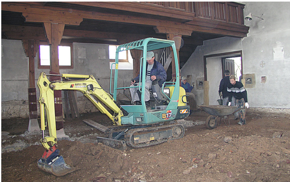
Mit einem Minibagger wurde das Erdreich in der Kirche ausgehoben.
