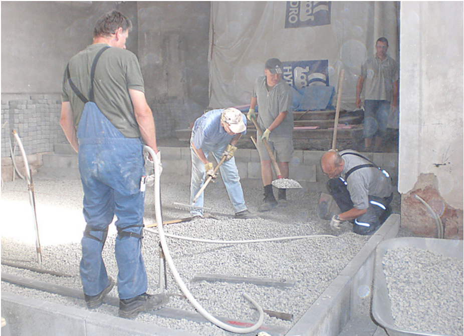
Einbau des Schotters im Altarraum
