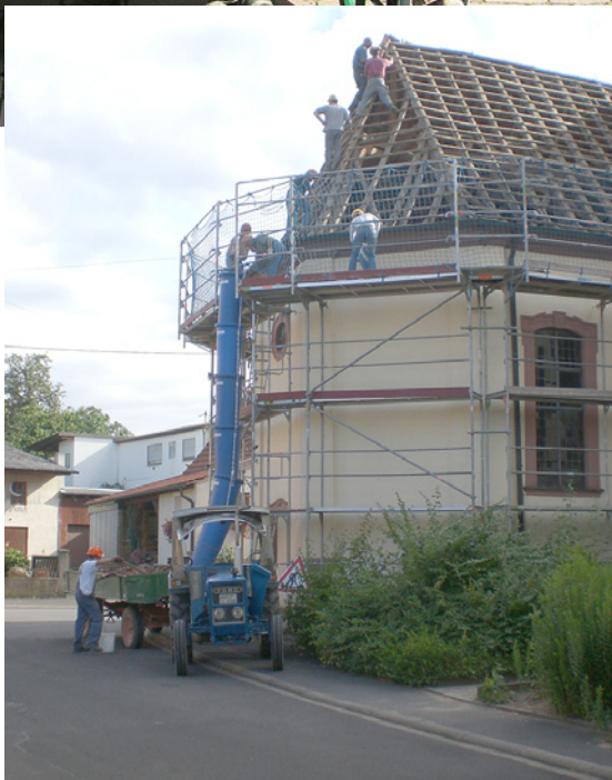
Dachsanierung an der Seitenkapelle
