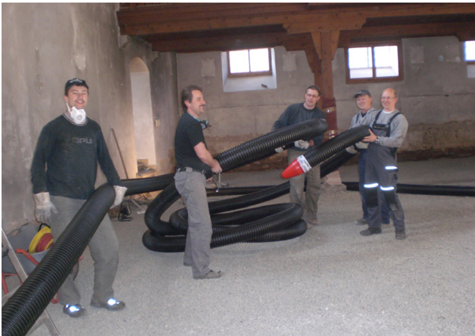
Die „Tunnelratten“ sind am Werk. Hier werden die Rohre für die Fußbodenheizung in die alten Luftschächte verlegt.
